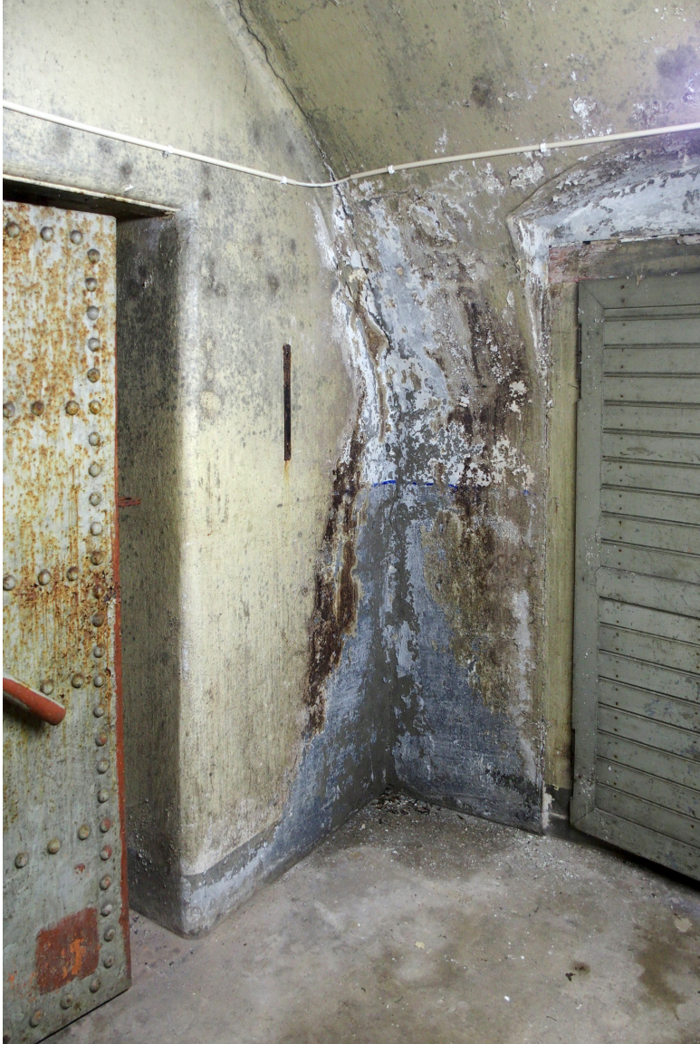
Eteistilan 02 kattoholvissa on näkyvissä muottilaudoituksen jäljet. Savupiippu ja sähköasennukset ovat 1930-luvulta.
