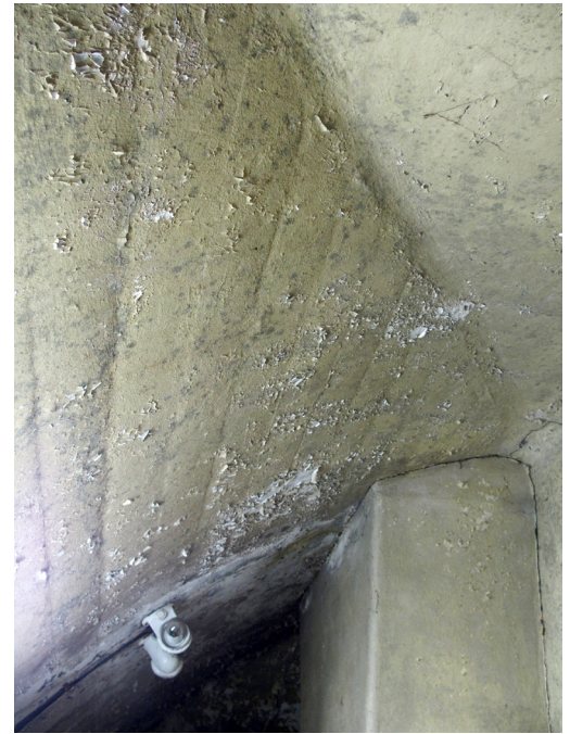
Eteistilan 02 kattoholvissa on näkyvissä muottilaudoituksen jäljet. Savupiippu ja sähköasennukset ovat 1930-luvulta.
