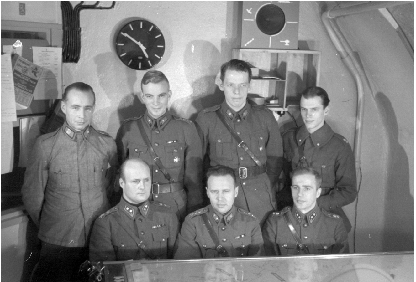
Ilmavalvonnan aluekeskuksen upseeristoa iv-tasohuoneessa tammikuussa 1942. Huone ei ollut vielä nykyisessä laajuudessaan. Ilmanvaihtokoneen ja sähköpääkeskuksen sisältävään eteistilaan johtava panssariovi jäi tuolloin vasemmalla näkyvän lasiseinän taakse. SA-kuva
