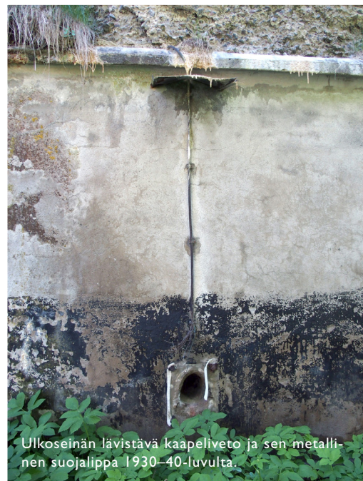
1930-luvun kaapelisuoja venäläisaikaisen julkisivun keskiosassa. Vuonna 1940 korotettu maanpinta on ulottunut tervatun alueen korkeudelle.
