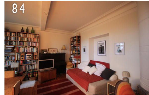
83–84 Sisätiloissa on säilytetty jälkiä rakennushistoriasta. Alkuperäisiin kantaviin seiniin liittyvät katto- ja jalkalistat on kunnostettu tai rekonstruoitu ja käytöstä poistetut oviaukot jätetty näkyviin syvennyksinä. Venäläisaikaiset sisäkaton palkit on säilytetty ja suomalaisaikaiset pystyuunit on kunnostettu tai rekonstruoitu ulkoasun osalta. Asunto 3.
