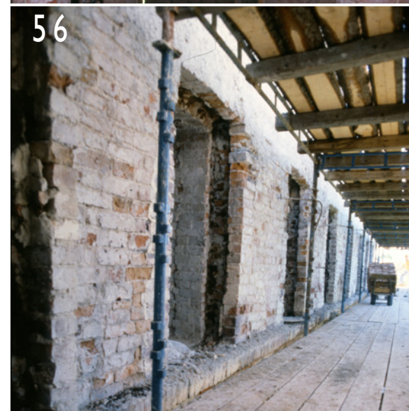
55–56 Porrashuoneen ja julkisivujen rappaukset uusittiin kauttaaltaan. Porrashuone 1. kerroksessa keskikäytävältä uloskäynnille katsottuna 1980 ja osa pääjulkisivua 1979. SLHka: CD/ID 0088/0012; 0088/0071.
